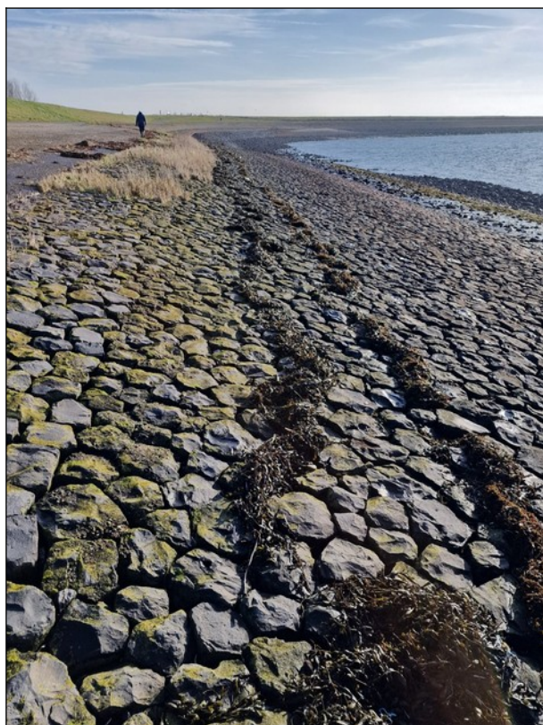
De zeedijk is bij de dakpannendam afwijkend, hij is hier bedekt met basaltstenen waarop boven het vloedmerk het gele korstmos Zeecitroenkorst.
